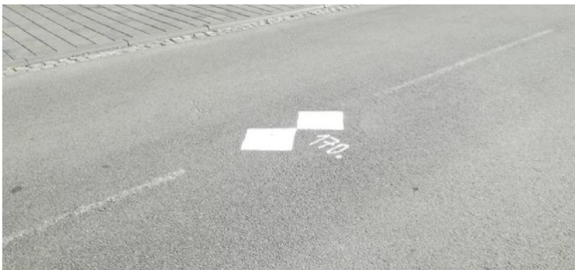
Obr. č. 1: Grafické značení vlícovacích a kontrolních bodů.
